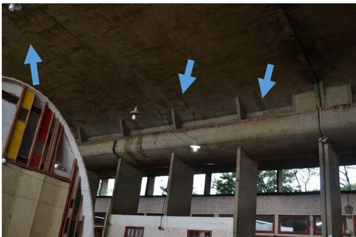
Figura 14: Fisuras en el techo de la Escuela Normal Superior Nº 1, Leandro N. Alem
